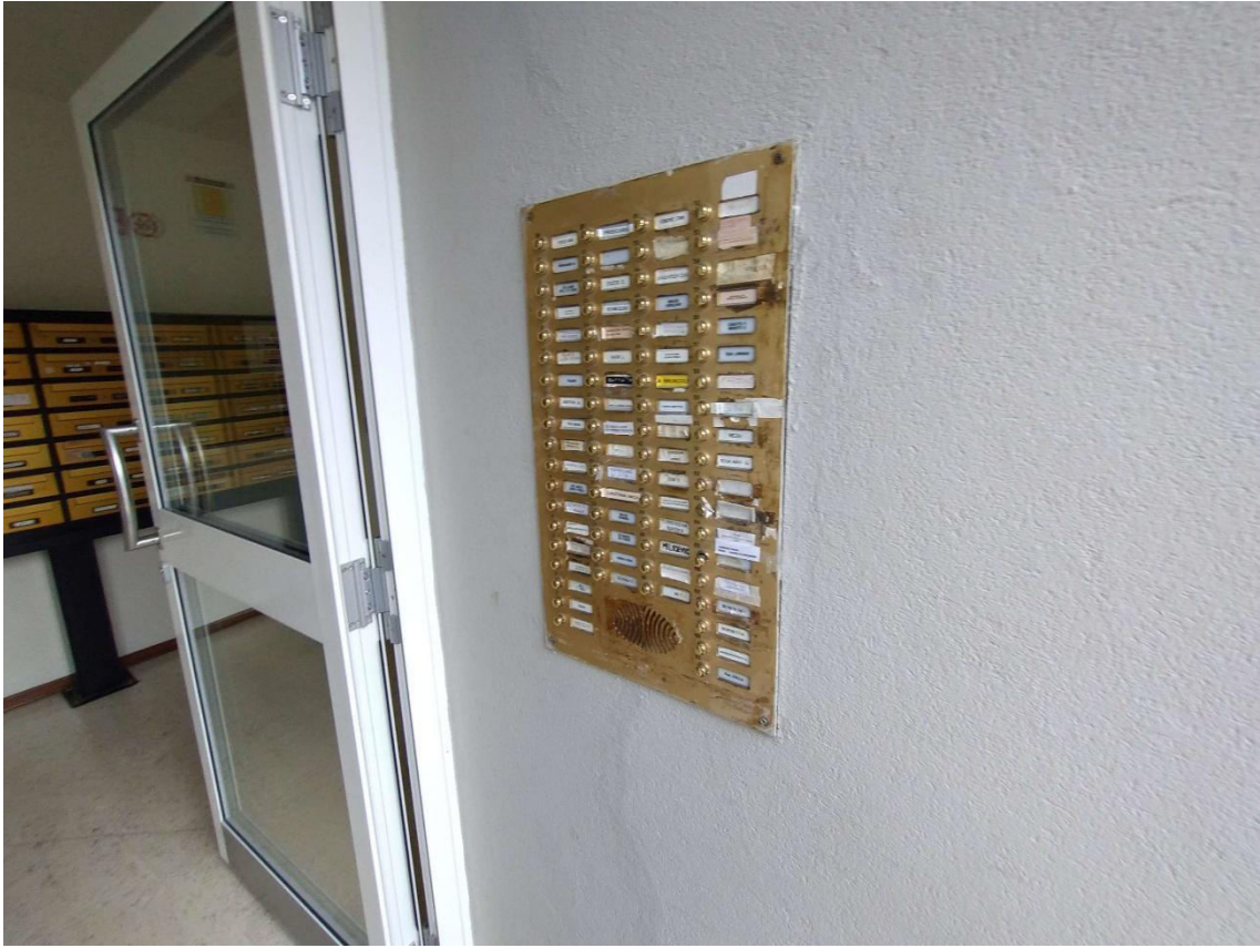
INGRESSO AL CONDOMINIO
